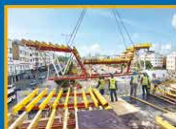
PONT DE DÉNIVELLATION DU BLVD MOHAMMED VI, CASABLANCA
